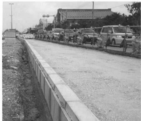
平成27年度 西崎地区舗装工事(施工中)
